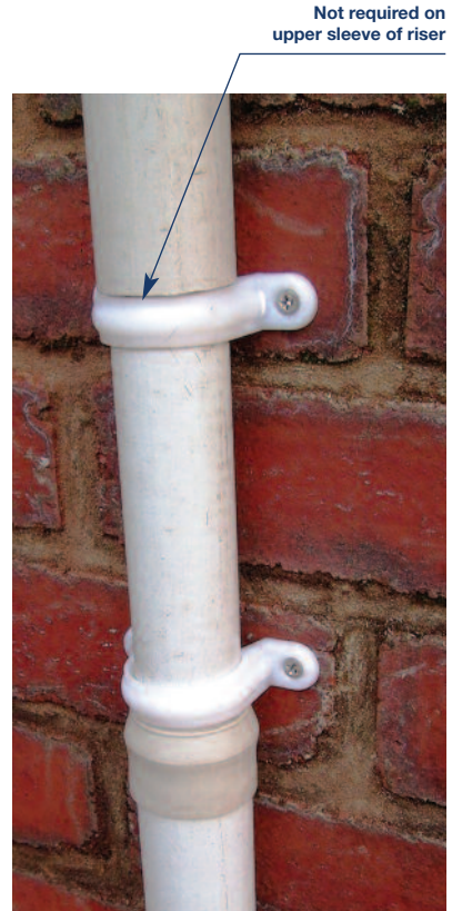
32mm PE Riser as shown
